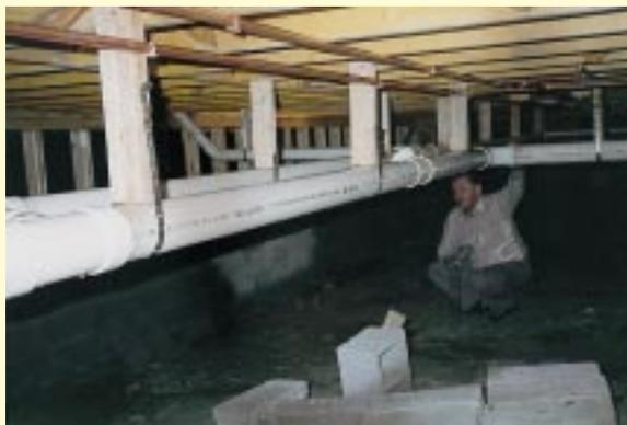
Die Leitungen werden einfach unter die Kellerdecke, die aus einer tragenden Holzbalkenkonstruktion besteht, gehängt
