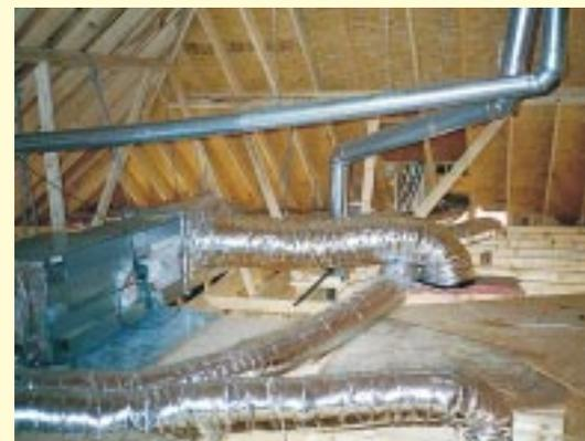
... unter dem Dach befindliche „Warmluft-Heizzentrale“ (Abgasrohr Mitte hinten)
