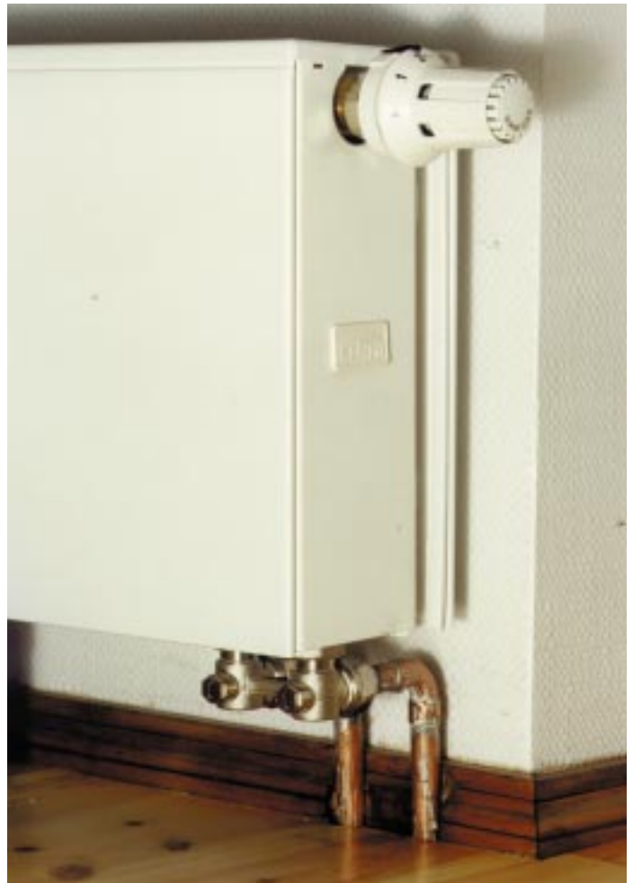
Immer häufiger sind auch Arbeiten wie diese „Schmierlötung“ zu sehen. Das Foto erhielten wir übrigens von einer PR-Agentur zur Illustration eines Presstextes
