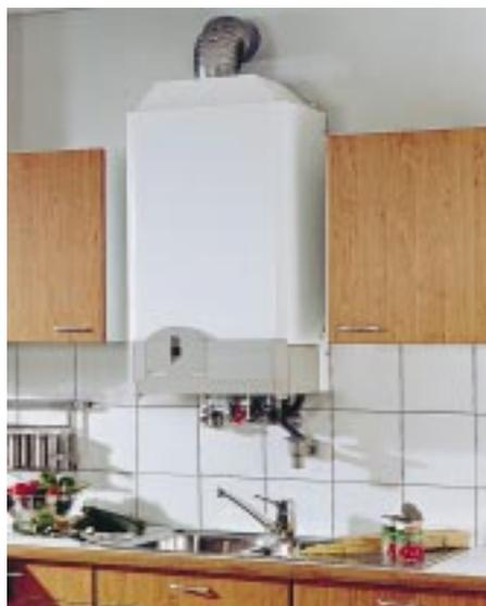
Die teilkondensierende Gas-Kesseltherme „Cerafur-Kamin“ läßt sich laut Junkers ohne Versottungsgefahr an nahezu jeder Abgasführung betreiben
