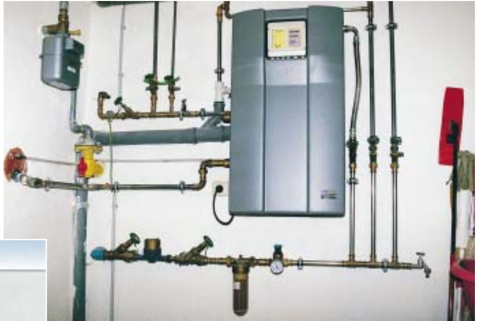
Die Regenwasserzentrale im Hause Fürbacher, an dessen linker Seite unten die Ansaugleitung und darüber die Verteilung der Regenwasseranlage angeordnet sind
