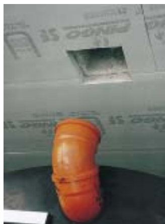
Zum Gebäude hin wird ein Leerrohr verlegt, in dem die Ansaugleitung und die Leitung der Druckschaltautomatik verlegt werden
