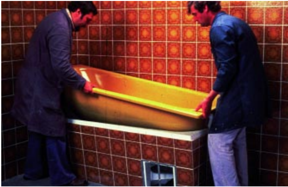
Was Heinz Bunten erfand: Die Wanne wird nach dem Verfliesen eingesetzt. Nur einer von zahlreichen Vorteilen des Wannenträgers
