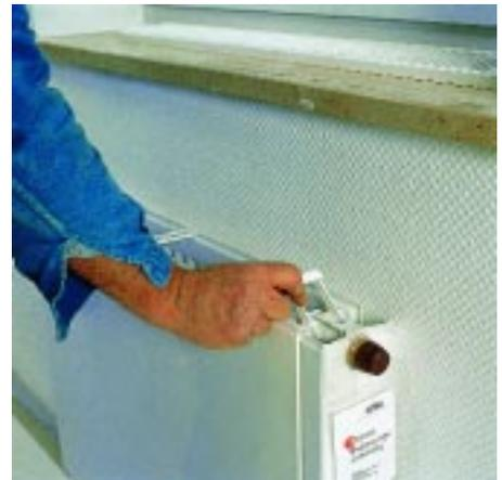
**Jetzt mußte der Heizkörper nur noch in die Senkrechte geschwenkt, in dieser Position verriegelt und das obere Abdeckgitter aufgesetzt werden**
