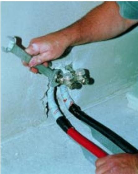
**Die Heizungsrohre wurden im Fußboden verlegt. Um Beschädigungen während der Bauarbeiten zu vermeiden, wurden die Rohre erst nach dem Verputzen angeschlossen**
