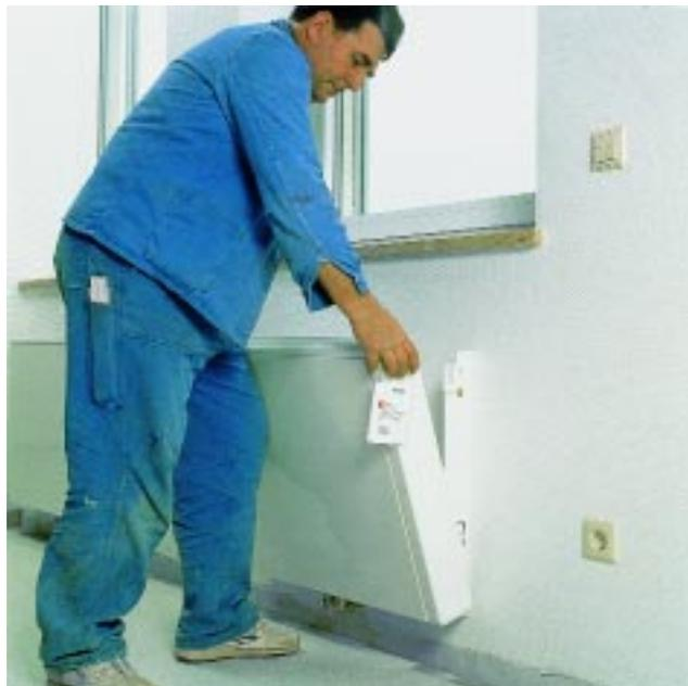
**Nach Abschluß der Bau- und Malerarbeiten wurden die Heizkörper angeliefert und montiert. Dazu wurden die Befestigungsschienen an die Wand geschraubt und die Heizkörper eingehängt**
