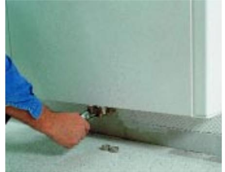
**Mit zwei Überwurfmutter befestigte der Monteur die beiden Rohre des Mittelanschlusses an der vor Monaten montierten Anschlußverschraubung**
