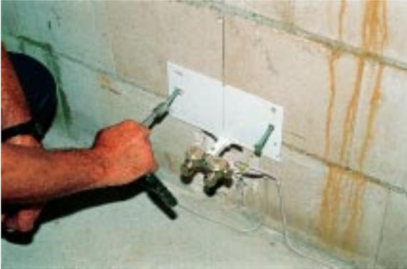
**Die Montage gliederte sich in zwei Phasen. Zunächst wurden die Anschlußplatten auf die unverputzten Wände montiert**
