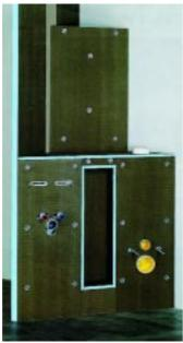
werden. Die Befestigung der Fliesenträger erfolgt mit selbstschneidenden Bohrschrauben und Dämmplattentellern an den Konstruktionsrahmen.
