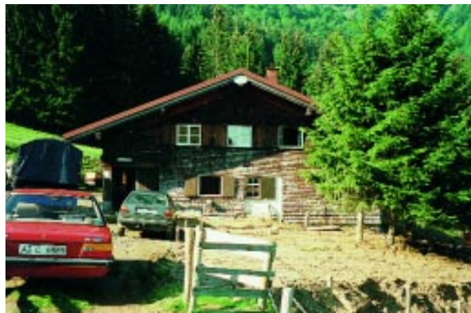
Unterhalb des Dennebergs liegt die Alpenhütte, für die dringend ein Klappenklosett gesucht wird
