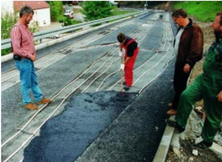
*Den Abschluß des Straßenaufbaus bildete eine etwa 5 cm hohe Tragschicht aus Walzasphalt. Die ummantelten Kupferheizungsrohre erwiesen sich als robust beim Ausrollen auf steinigem Baugrund*
