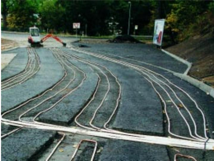
*Die mittels Lochband auf dem Untergrund befestigten ummantelten Kupferheizungsrohre wurden zunächst mit einer Schicht aus Gußasphalt bedeckt*
