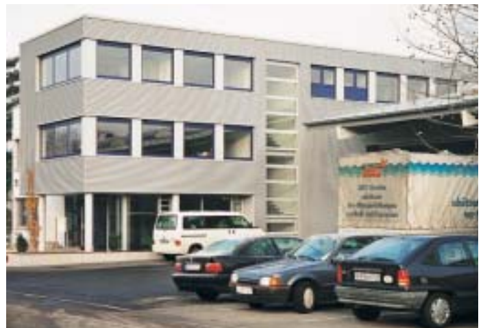
Der dreistöckige Gebäudeteil im Judo-Werk in Backnang-Waldrems ist neu entstanden
