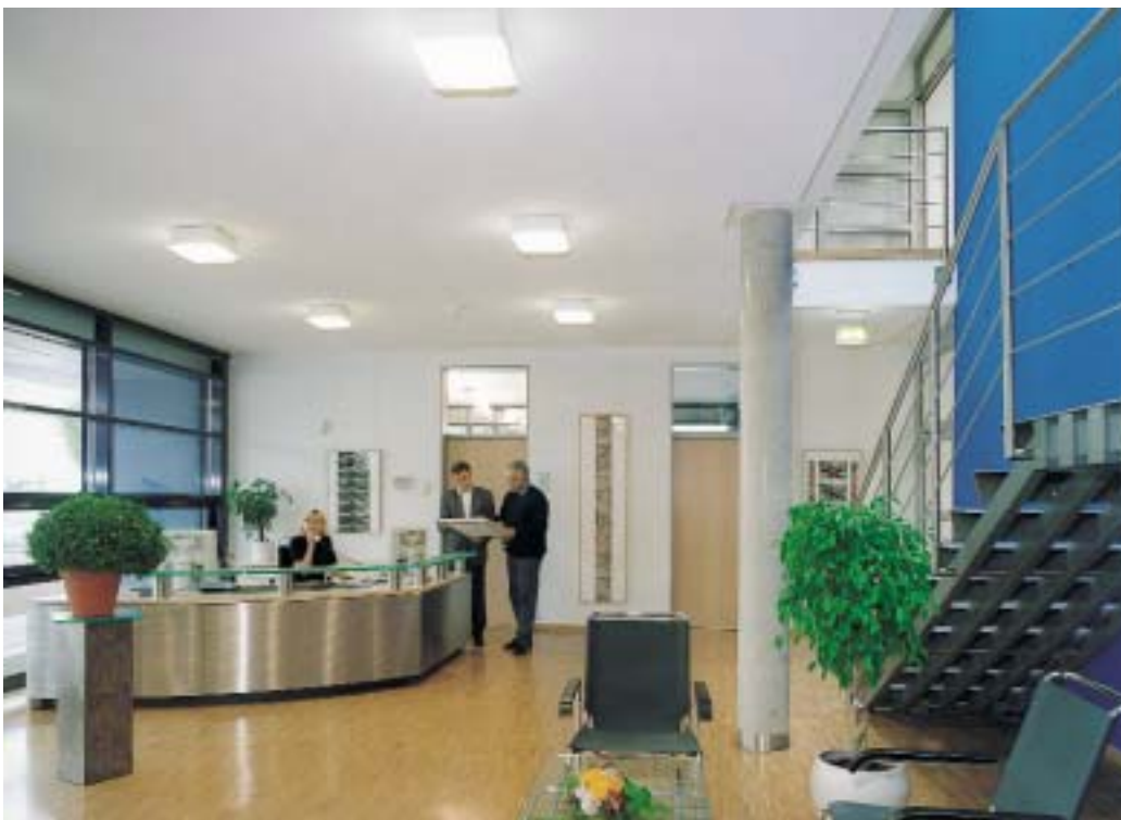
Der relativ hohe Eingangsbereich wird auf einer Fläche von 100 m 2 über eine Fußbodenheizung beheizt
