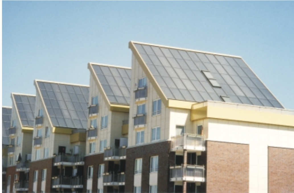
Sonnensiedlung Helios, Rostock
