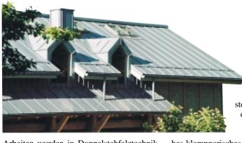
Arbeiten wurden in Doppelstehfalztechnik auf dem Dach und in der Fassade als Winkelfalztechnik ausgeführt. Als Material kam Alcan Farbaluminium in der Farbe Taubenblau zum Einsatz. Für die Windfederbekleidungen und den Lüftungsfirst wurde Prefa Farbaluminium SP 80 in Taubenblau und Weiß verwendet. Für Dachrinnen und Fallrohre wurde ebenfalls Prefa verwendet. Die Dachfläche eines Hauses beträgt rund 300 m². Für Fassade und Innenbereich der Loggia wurden rund 85 m² Farbaluminium verarbeitet.
