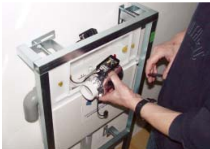
Wird nicht in die Wand, sondern in den Spülkasten eingebaut: Der Smell Stop von Toralf Hansen
