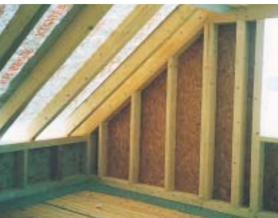
Innenansicht der Holzrahmenelemente: eingesetzt sind 16 mm dicke Holzrahmen, außen beplankt mit Spanplatten
