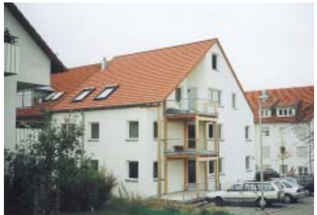
Außenansicht des Minimalenergiehauses, bei dem die Holzbalkone vom Gebäude vollständig getrennt sind
