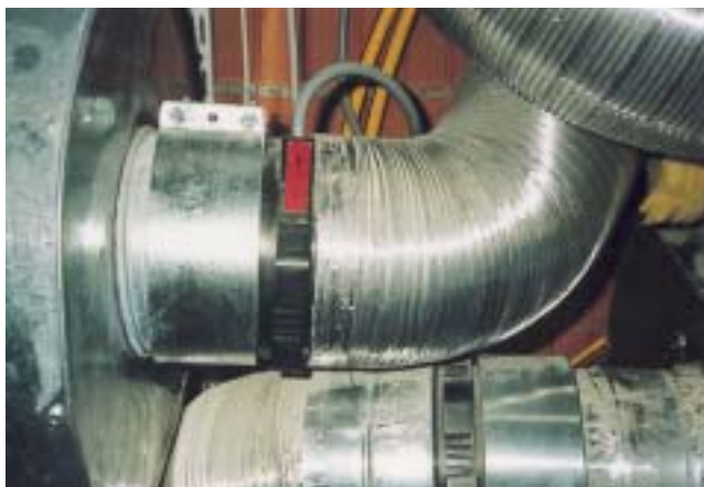
Rohreinschubventilatoren mit verbessertem Gleichstrommotor. Die Ventilatoren werden mitsamt dem Rohr gedämmt und sind dann von außen nicht mehr sichtbar
