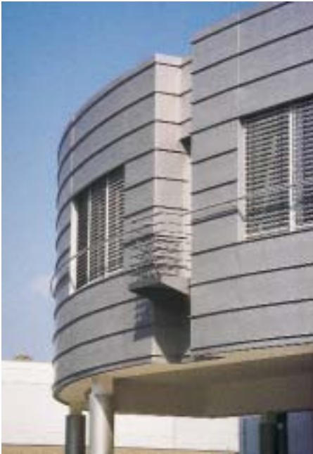
Bild 5 Traditionelle Falztechnik und Kleben ergänzen sich an dieser Edelstahlfassade
