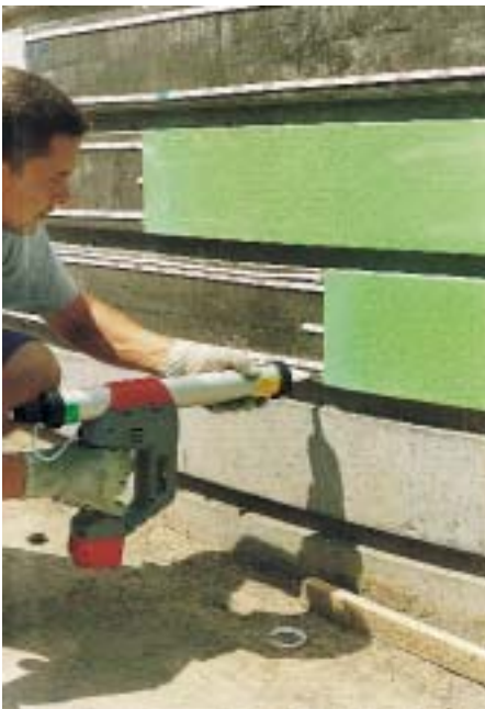
Bild 4 Auftragen des Klebstoffes zum Verkleben der Paneele an der gerundeten Wand der Unterführung
