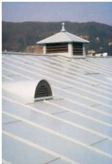
Die Schleppgauben wurden bei diesem 8° flachem Dach aus Falzonal eingeklebt und gleichzeitig eingedichtet
