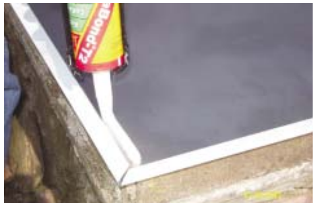
Bild 2 Den Kleber mit einer Dreiecksraupe aufziehen und dabei die Pistole senkrecht halten
