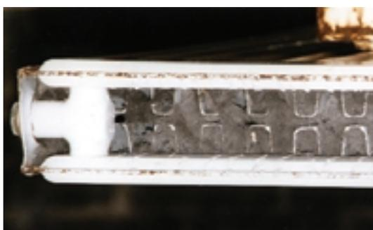
Verminderte Leistung durch Flusen: Der Heizkörper lieferte nur noch Strahlungs- und keine Konvektionswärme
