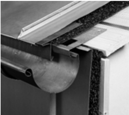
Unter Metalldeckungen haben strukturierte Trennlagen vielfältige Funktionen
