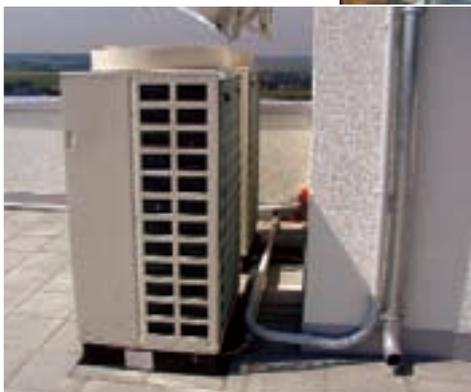
Am Sachsenring wurden zwei Außeneinheiten mit insgesamt 21 Innenteilen installiert. Fast alle Innenteile sind 2-Wege-Kassetten, die für schmale Räume gut geeignet sind. Die Kühlleistung beträgt 2,8 kW, die Heizleistung 3,3 kW
