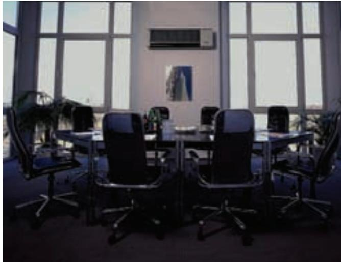
**Split- bzw. Multisplit-Geräte erzielen eine Kühlleistung von ca. 3 bis 15 kW und eignen sich für die Kühlung von Räumen mit bis zu ca. 35 m<sup>2</sup> Grundfläche**
