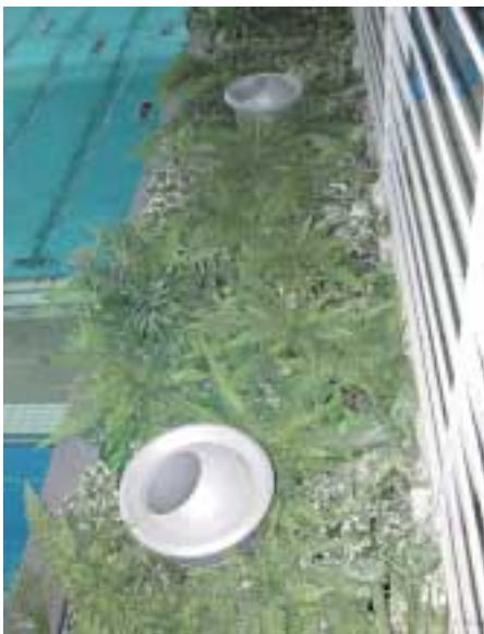
... gut versteckt mittels Weitwurfdüsen, ...
