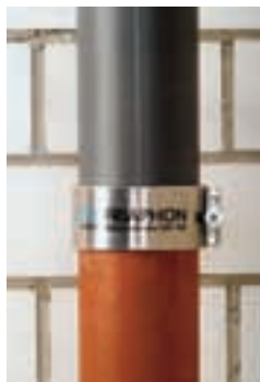
Der Friaphon-Spannverbinder ermöglicht den Übergang auf gußeiserne Leitungssysteme
