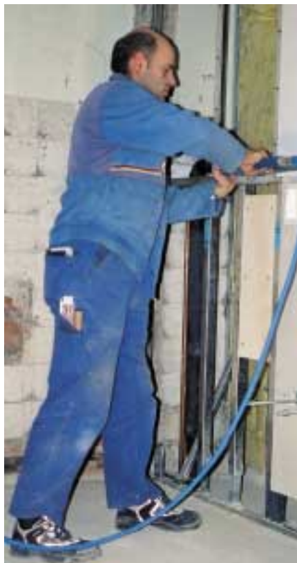
Mit dem Speedtacker konnte Obermonteur Peter Höffner die Fermacell-Platten Zeit sparend befestigen
