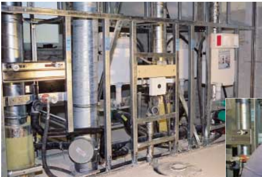
VariVit-Trennwand mit gesamter Sanitärtechnik (v. l.): Waschtisch-, Urinal- und WC-Element
