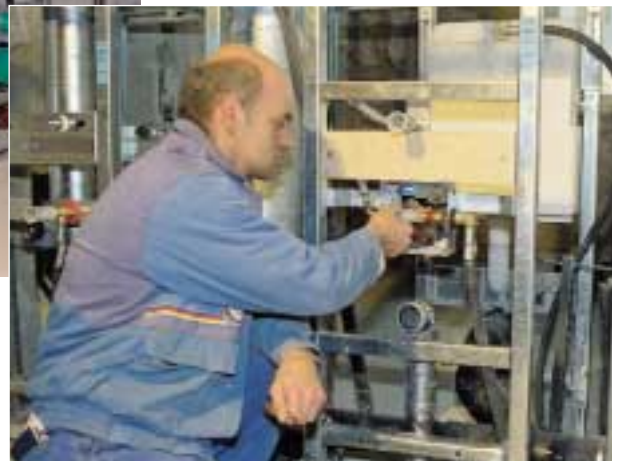
Die Urinalspülautomatik ist im VariVit-Urinalelement bereits vormontiert
