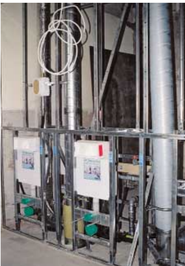
Das Installationssystem VariVit mit WC-Elementen und Sanicontrol UP-Spülkasten
