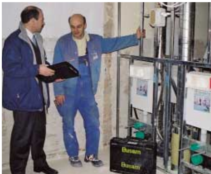
Mepa-Gebietsleiter Axel Cyrus (l.) und Peter Höffner bei der Baustellenbesprechung
