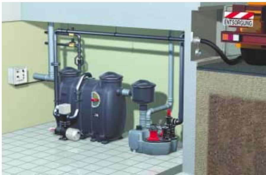
Bild 4 EN-Fettscheideranlage mit Entleer- und Spüleinrichtung
