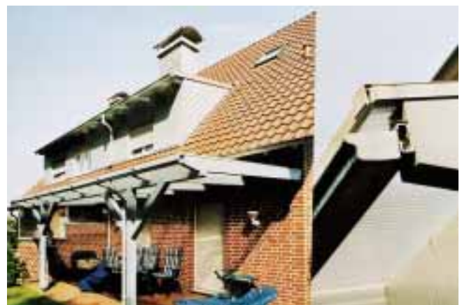
Bild 5 Balkon-Steckrinne, Einbausituation Terrassen-Überdachung
