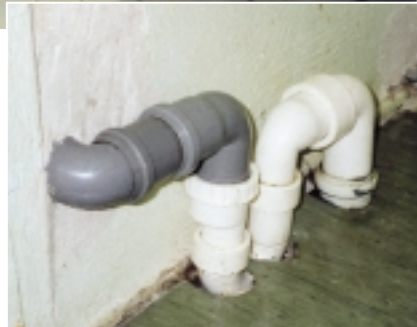
Außergewöhnlicher Siphon: In der Herrentoilette sind vier Urinale angeschlossen. Der erforderliche Geruchverschluss wurde hinter der Wand in der Damentoilette angebracht
