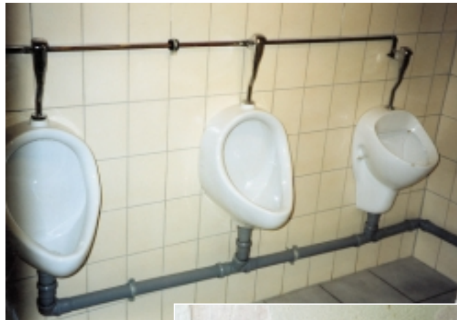
Außergewöhnlicher Siphon: In der Herrentoilette sind vier Urinale angeschlossen. Der erforderliche Geruchverschluss wurde hinter der Wand in der Damentoilette angebracht
