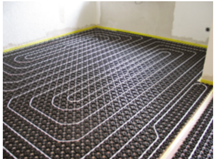
Verlegung des PE-Xa Rohres (9,9 x 1,1 mm) in den vorgefertigten Noppen des Folienelements
