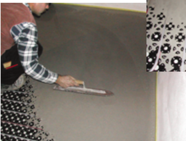
Beim „minitec“-System sorgen werkseitig eingestanzte Löcher für den Haftverbund der Ausgleichsmasse mit dem Untergrund
