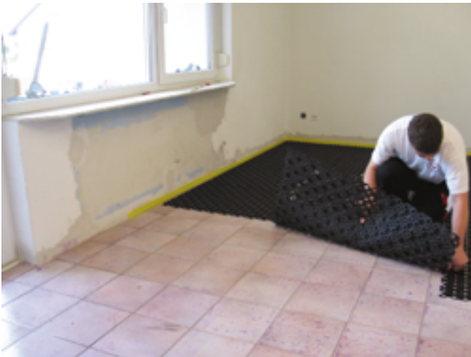
Die Verlegung des selbstklebenden Folienelements beginnt in der rechten Raumecke
