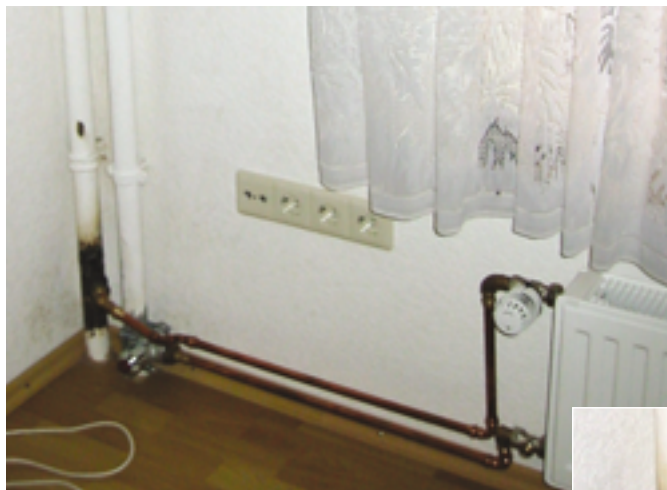
Bild 2 und 3 Der Rücklauf wurde durch ein Explosions-T-Stück mit der verzinkten Gasleitung (rechts) verbunden
