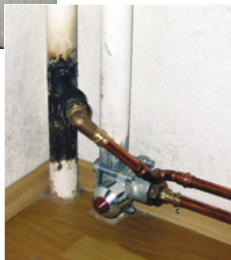
Bild 2 und 3 Der Rücklauf wurde durch ein Explosions-T-Stück mit der verzinkten Gasleitung (rechts) verbunden
