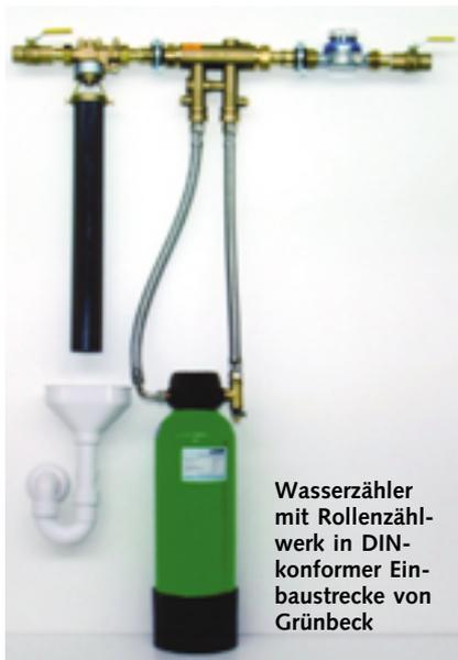
Wasserzähler mit Rollenzählwerk in DIN-konformer Einbaustrecke von Grünbeck
