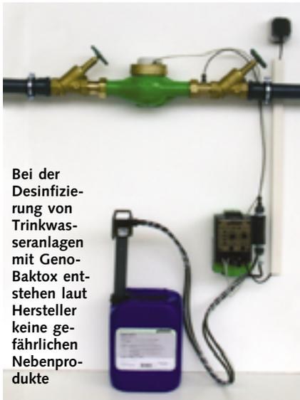
Bei der Desinfizierung von Trinkwasseranlagen mit Genobaktox entstehen laut Hersteller keine gefährlichen Nebenprodukte
