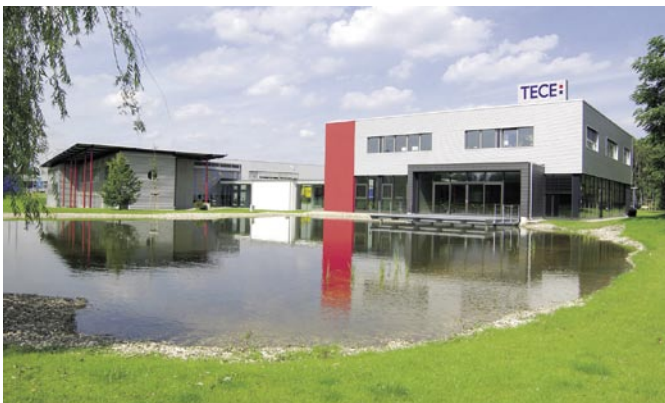
Das neue Schulungszentrum von Tece
