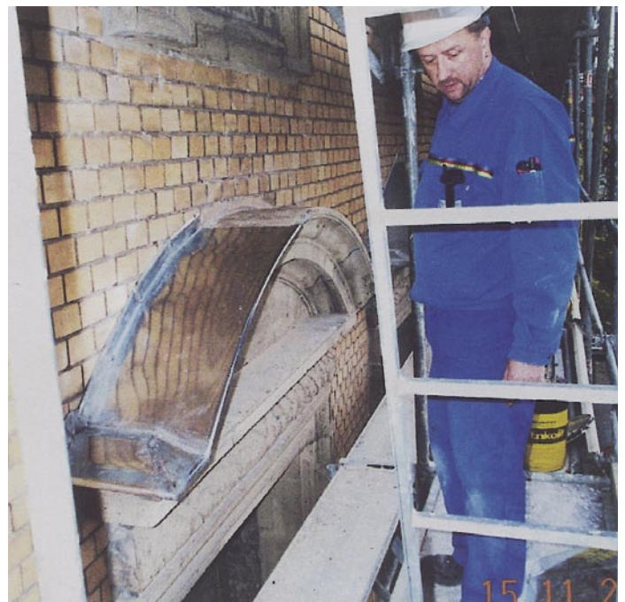
...hier sieht man das fertig aufgeklebte Teilstück der Abdeckung
