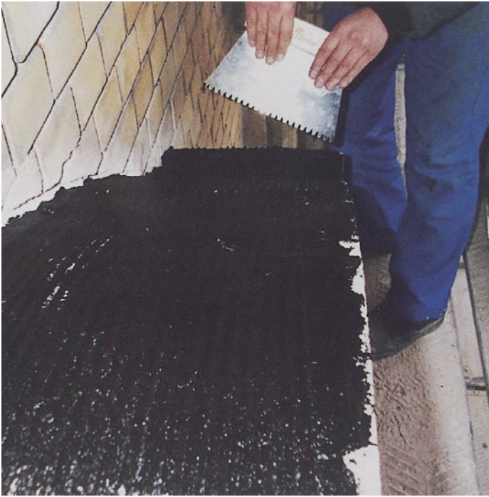
Auf der Baustelle: Blech-Kaltkleber ist mit dem Rillenspachtel aufgebracht...
