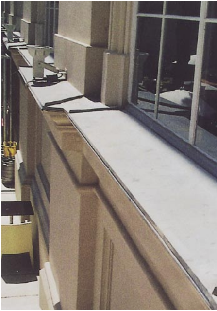
Auch stark gegliederte und verspringende Abdeckungen werden in Klebtechnik ausgeführt
