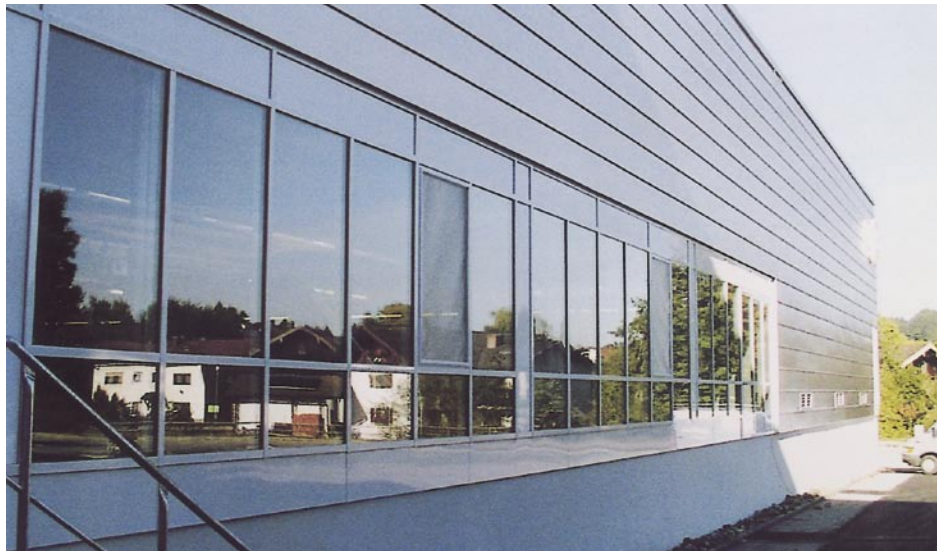
Bei Fassadenbekleidungen in den am Bau üblichen Metallen dient die Klebetechnik oft als zusätzliche Sicherheitsmaßnahme
