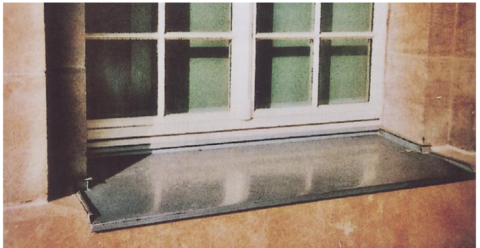
Außenfensterbänke sind ein typisches Beispiel für das Arbeiten mit Blech-Kaltklebern
