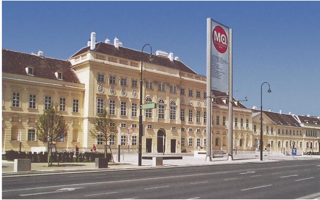
Bei der Renovierung des Museumsquartiers in Wien wurden zahlreiche Abdeckungen und Anschlüsse geklebt
