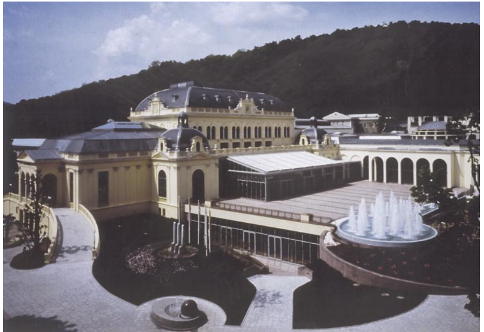
Die Klebtechnik wird bei Alt- und Neubauten erfolgreich eingesetzt; auch bei der Renovierung des Casinos in Baden bei Wien
