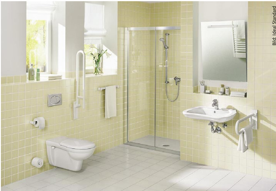
Stützklappgriffe lassen sich nachträglich leicht montieren, wenn hierfür gleich bei der Planung die notwendigen Vorkehrungen getroffen werden
