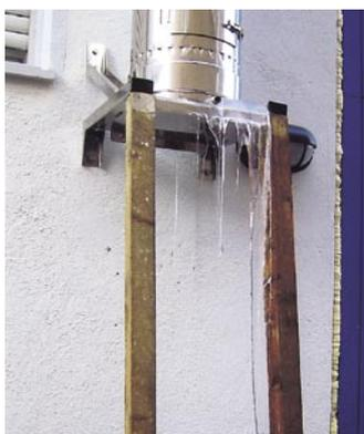
**Problem:** Die Abgase kondensieren in der Abgasleitung und sammeln sich am Boden des Edelstahlkamins
