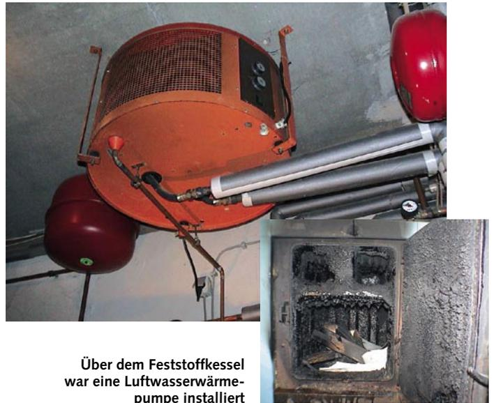
Über dem Feststoffkessel war eine Luftwasserwärmepumpe installiert
