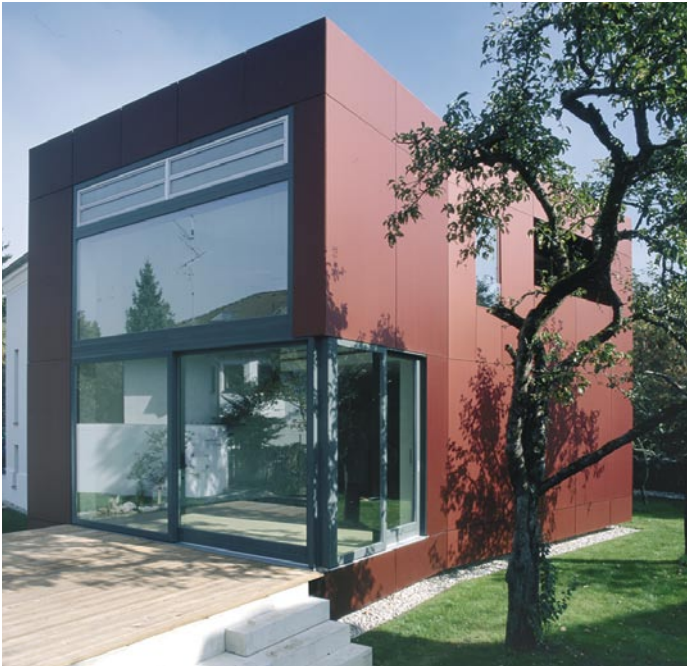
Den zweiten Platz erzielte die eigenständige Ergänzung von „Haus Jauch“ in Klempnertechnik mit markanter Farbgestaltung
