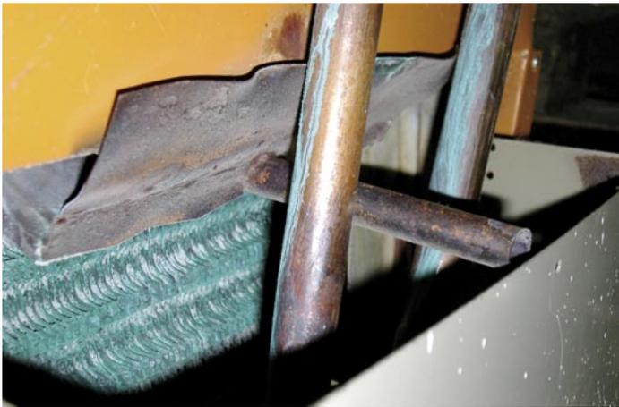
**Brennwertanlage erwünscht? Kein Problem: Man bastle einfach den Wärmetauscher aus einer T2 in den Abgasweg eines Wolf-Kessels**
