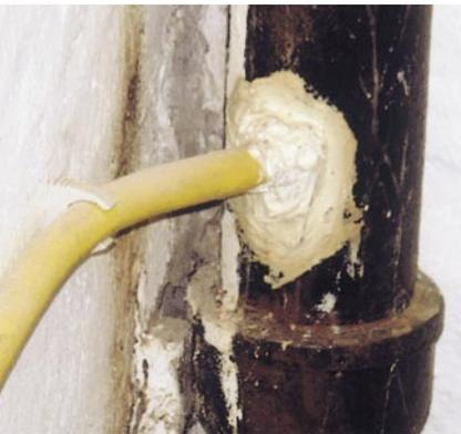
**Kondensatanschluss fachgerecht abgedichtet mit Montageschaum**
