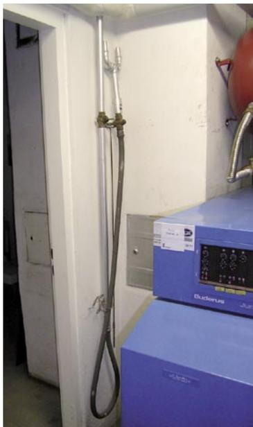
**Nur mittels Kegelhahn abgesperrt und ungesichert fristete dieser alte Gasanzünder jahrelang sein gefährliches Dasein**
