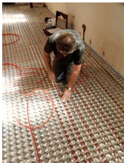
Rund 1700 m sauerstoffdiffusionsdichtes PE-Rohr Ø 8 mm wurden in die Systemelemente eingezogen
