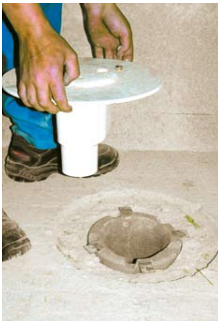
Bild 6 Montage des Brandschutz-Bodenablaufes
