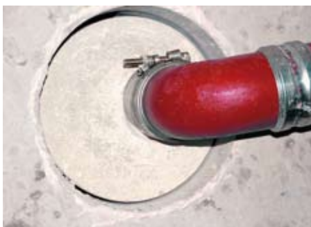
Bild 7 Anschluss der Rohrleitung
