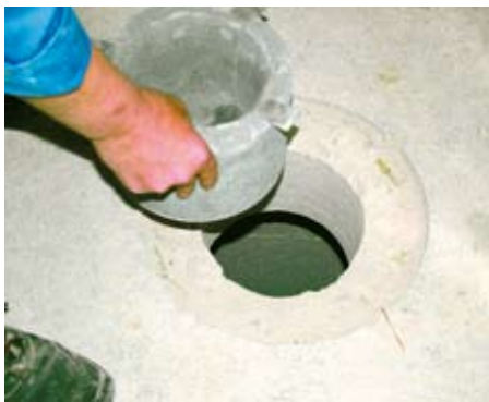
Bild 5 Einsetzen des Einbausets
