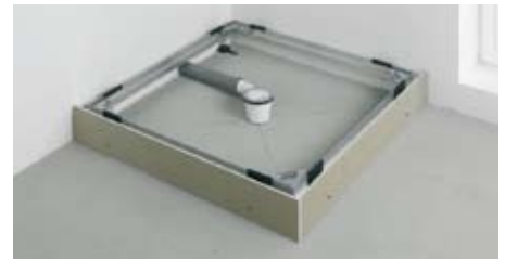
Im zweiten Schritt werden Ablauf und Siphon vorbereitet und die mitgelieferten Schalungshilfen befestigt
