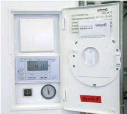
Das Kesselbedienmodul enthält u. a. das beleuchtete Display, an dem sich alle Daten einstellen und ablesen lassen
