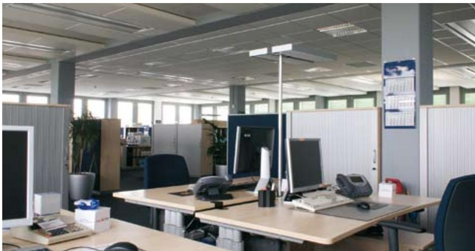
Auch nachträglich zu realisieren: wasserbasierte Klimasysteme. Hier wurden in den Büros Kühlbalken eingebaut
