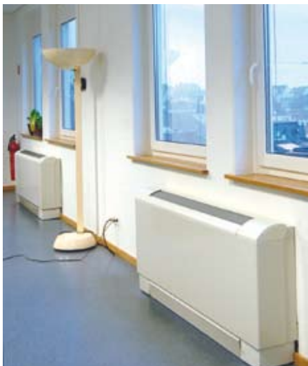
Standard-Installation für einen Fan coil: freistehend mit eigener Geräteverkleidung sorgt er vor Fenstern für das gewünschte Klima
