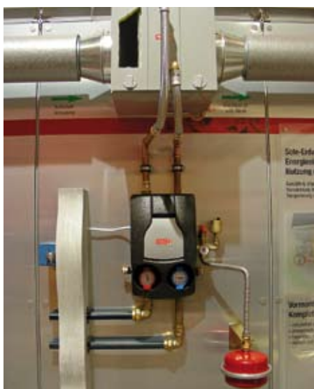
Nicht jeder glaubt an die hygienische Unbedenklichkeit von Erdwärmetauschern. Als Alternative bietet Helios eine Erdsondenlösung als Vorwärmer/Vorkühlung an
