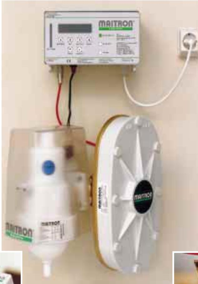
... in Kombination mit einem Rückspülfilter wird es als Modell „Combi“ über ein Y-Stück (r.) direkt an der Wand befestigt. Die elektronische Steuerung sendet Stör- und Info-Signale an das außerhalb des Aufstellungsraumes benutzbare Tochtergerät (l.)
