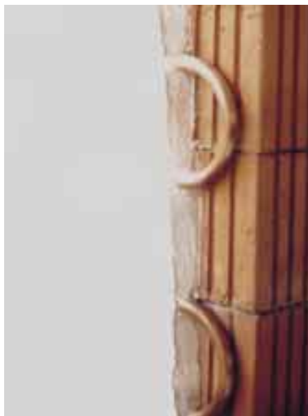
Bild 12 Putzaufbau des „Hypoplan“-Kupferrohrregister
