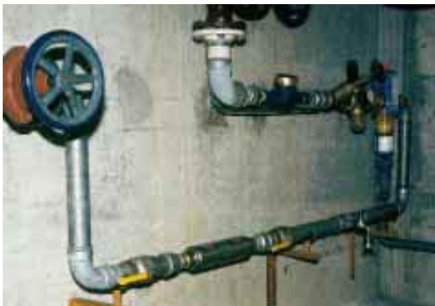
Bild 5 Der Umweltbeauftragte des Bischöflichen Ordinariates ließ die Ionentauscher-Anlage eines der sieben Häuser gegen ein permanentmagnetisches Wasserbehandlungsgerät austauschen. Vergleichende Untersuchungen anhand von Prüfstrecken sprachen für die Umrüstung aller sieben Häuser
