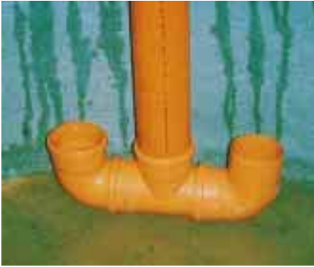
Bild 4 Beruhigter Regenwasserzulauf im Speicher durch Strömungsumlenkung. Die Verdoppelung des Querschnittes bewirkt die Reduzierung der Strömungsgeschwindigkeit auf ein Viertel
