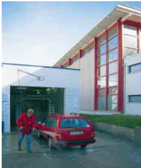
Gewerbliche Kfz-Waschanlage Fa. Bommer, Überlingen: Das Dachwasser der benachbarten Schulturnhalle wird übernommen und mit dem eigenen Regenertrag zusammen aus der 50 m 3 -Zisterne in den Waschwasser-Recycling-Kreislauf anstelle von Trinkwasser eingespeist
