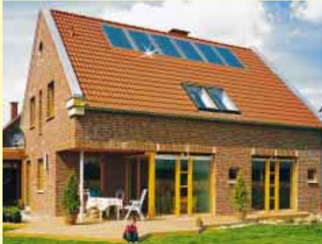
Bild 2 Zunehmend gefragt sind Solarkollektoren nicht nur zur Warmwasserbereitung sondern auch zur Heizungsunterstützung
