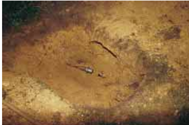
Bild 6 Hat die HAE erst mal Temperaturen um 800 °C erreicht, muß zur Unterbrechung der Gaszufuhr die Hausanschlußleitung freigelegt und getrennt oder abgequetscht werden
