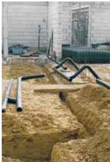
Die Teilstrecken wurden spiegelgeschweißt, die Vor-Ort-Verbindungen mit Elektroschweißmuffen erstellt
