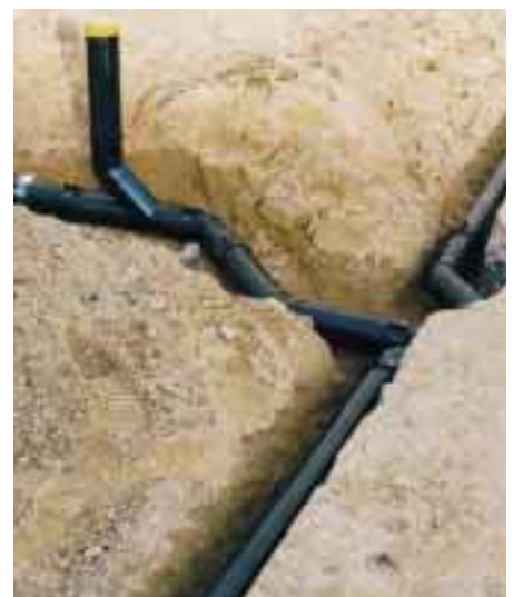
Die vorgefertigten Leitungsabschnitte werden auf der Baustelle angeliefert
