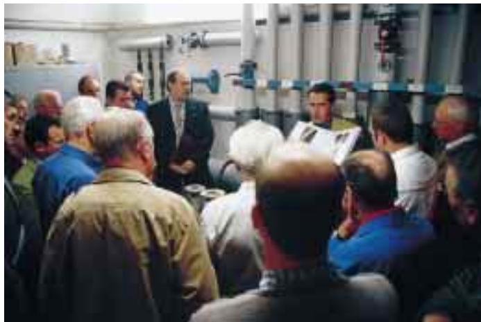
Insgesamt elf permasolvent-Geräte beugen in der Rohräckerschule Kalk und Korrosion vor
